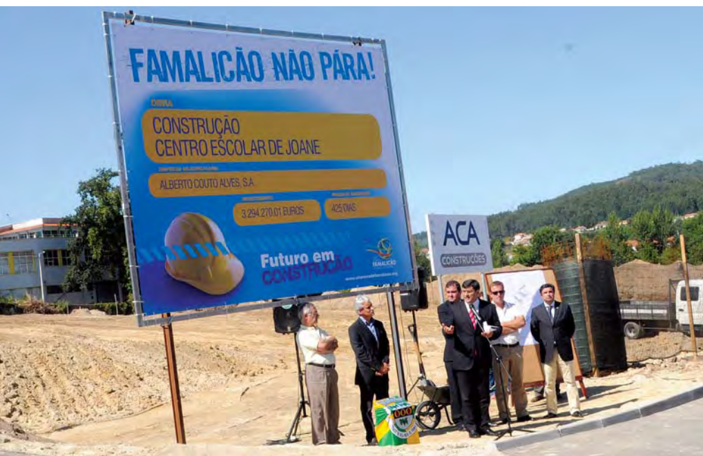
O Centro Escolar de Joane, já em construção, é o maior investimento municipal de sempre na vila
