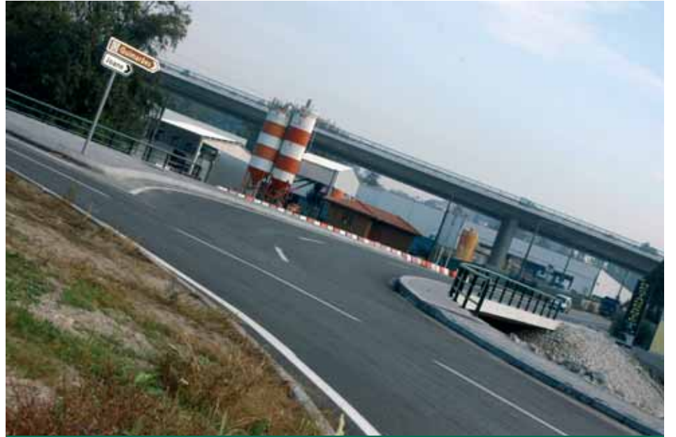
Nova ponte sobre o rio Pelhe, na Avenida do Brasil, em Gavião
