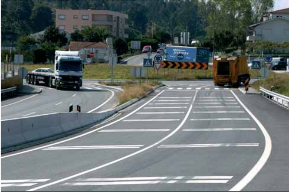
Rotunda de acesso à variante na Estrada Porto-Braga, em Calendário
