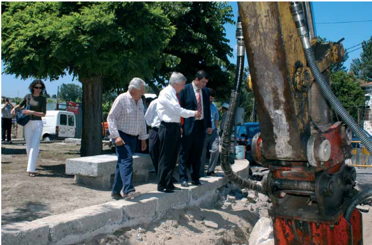
Ampliação das infra-estruturas básicas prosseguem a grande ritmo – na imagem, visita à obra de saneamento em Bairro
