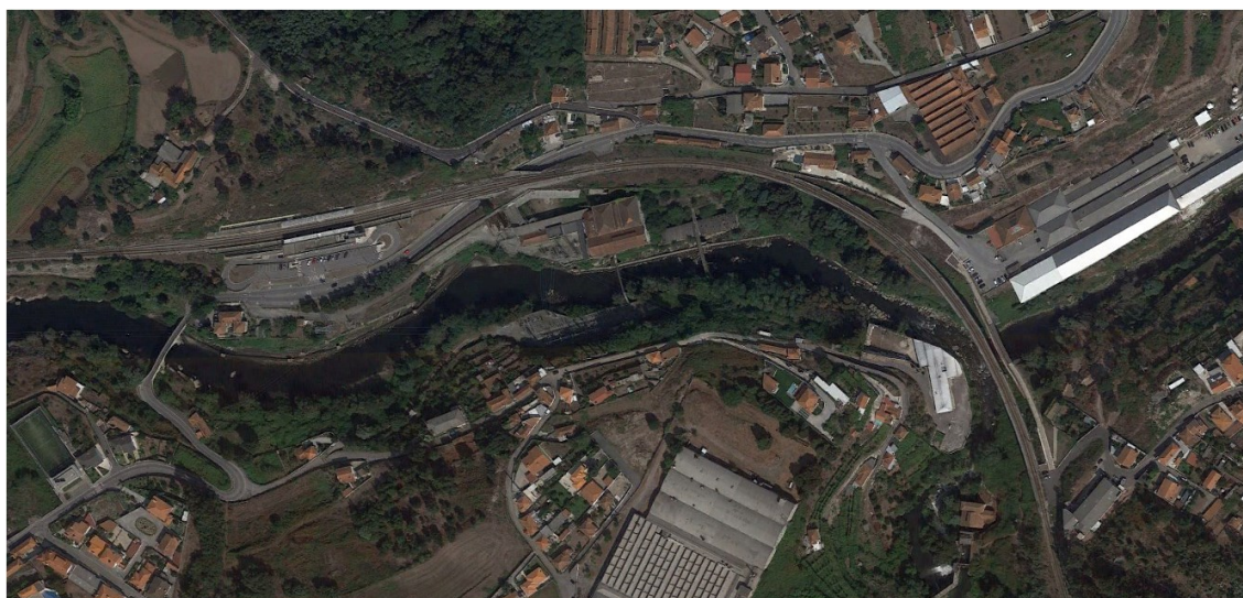
Pontes de Caniços e Estação Ferroviária
