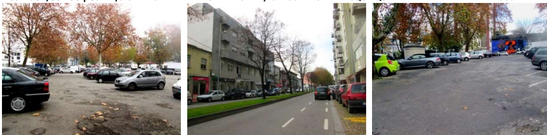
FIGURAS 54, 55 E 56 | CONDIÇÕES DE MOBILIDADE PEDONAL NAS PRAÇAS MOUZINHO DE ALBUQUERQUE E D. MARIA II E NA AV. NARCISO FERREIRA
