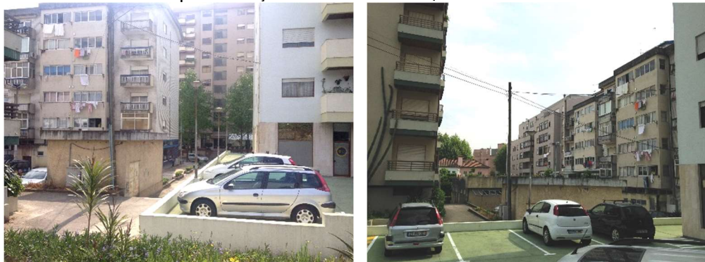
FIGURAS 38 E 39 | DESARTICULAÇÕES NO INTERIOR DOS LOTES E QUARTEIRÃO – TRAVESSA DOS EIXIDOS
