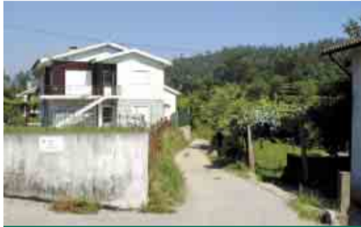
ARNOSO SANTA EULÁLIA Reconstrução da Rua do Alerta (obra protocolada)
