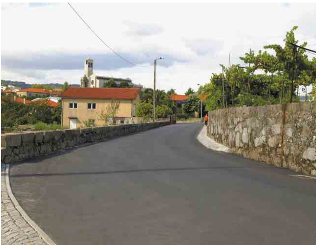
JOANE Renovação da Rua de Telhado
