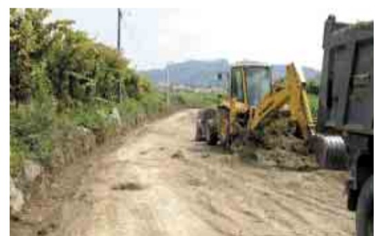
BENTE Rectificação e pavimentação da Rua dos Murtórios
