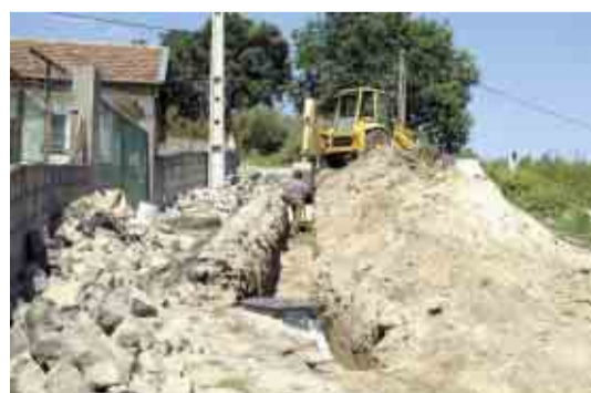
OLIVEIRA SANTA MARIA Construção da rede de saneamento básico
