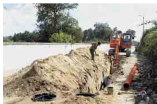
OLIVEIRA SÃO MATEUS Construção da rede de saneamento básico
