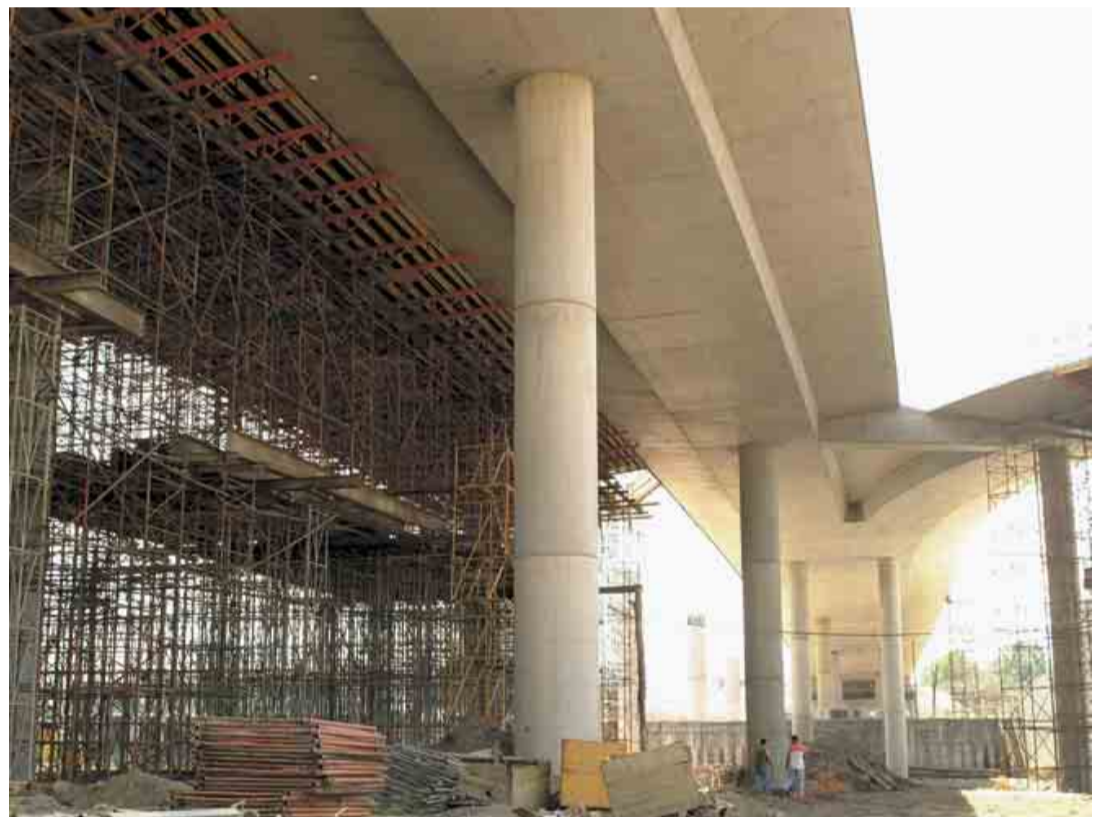
GAVIÃO Construção da Variante Nascente à Cidade
