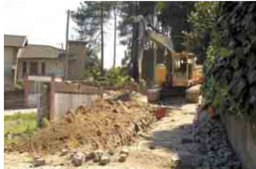
PEDOME Construção da rede de saneamento básico
