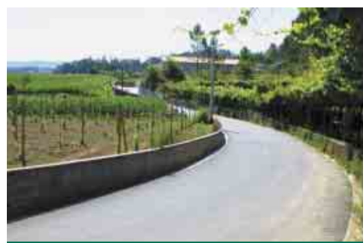
VILARINHO DAS CAMBAS Pavimentação da Rua da Fontela
