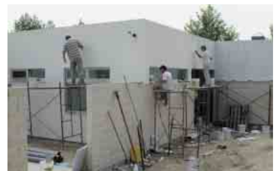
LAGOA Construção do jardim-de-infância
