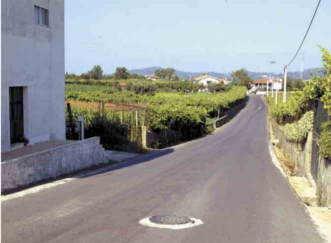
LEMENHE Reconstrução da Estrada Municipal 571-2
