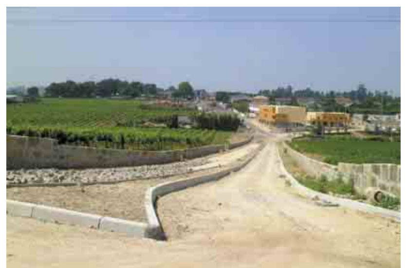
RUIVÃES Construção da Avenida Engenheiro Álvaro Pimenta
