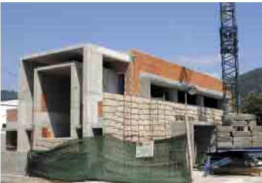
TELHADO Construção da Sede de Junta de Freguesia
