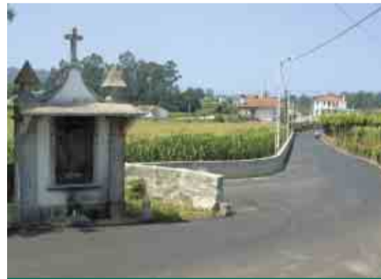
CAVALÕES Pavimentação da Rua do Senhor da Boa Fortuna
