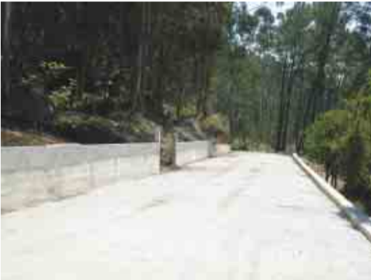
SEZURES Pavimentação do CM de acesso à Capela S. Vicente
