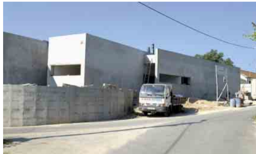
MOUQUIM Construção de jardim-de-infância
