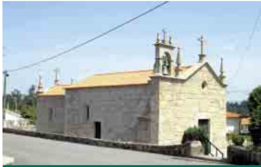
ABADE DE VERMOIM Restauro da Igreja Paroquial
