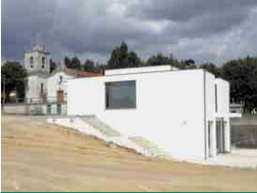
SÃO SIMÃO DE NOVAIS Construção da capela mortuária
