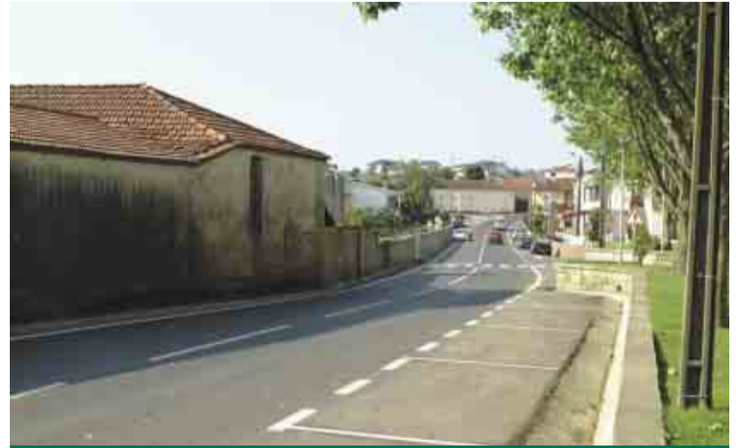
FRADELOS Pavimentação do Caminho Municipal 1496 (Corga- Pedras Ruivas)
