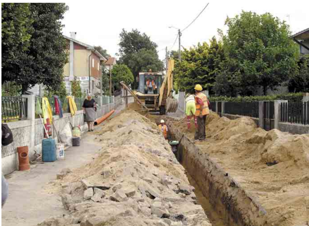
BAIRRO Construção da rede de saneamento básico
