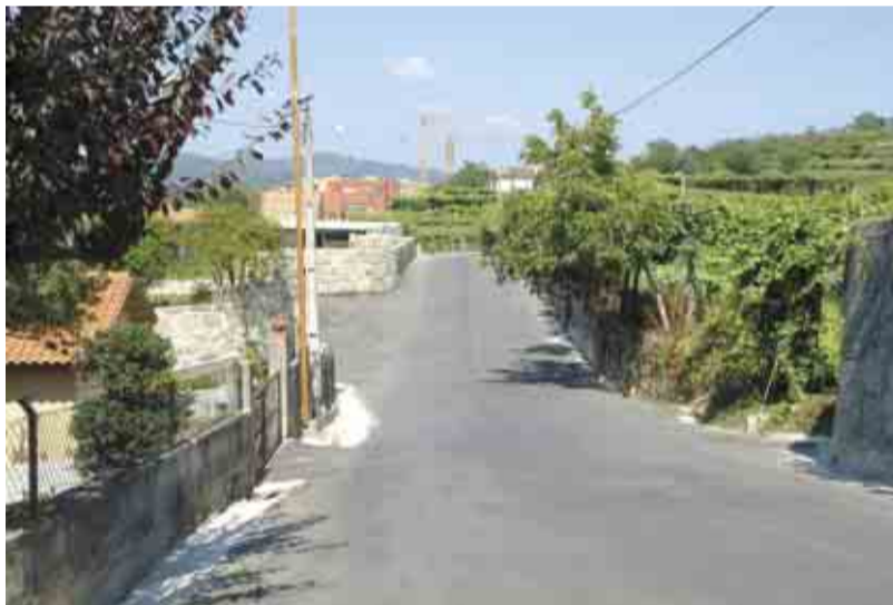
ARNOSO SANTA MARIA Reconstrução da Rua de Ferrão
