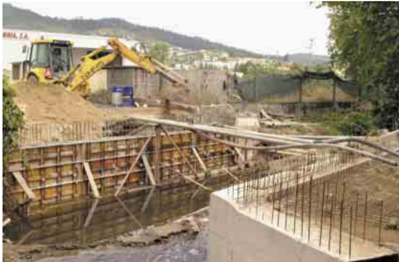
POUSADA DE SARAMAGOS Reconstrução da Ponte Nova
