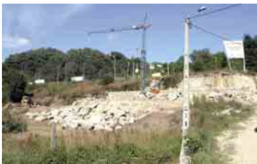
JESUFREI Infra-estruturas da Sede de Junta e jardim-de-infância
