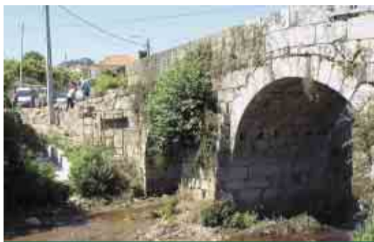
GONDIFELOS Beneficiação e reforço da estrutura da Ponte da Gravateira
