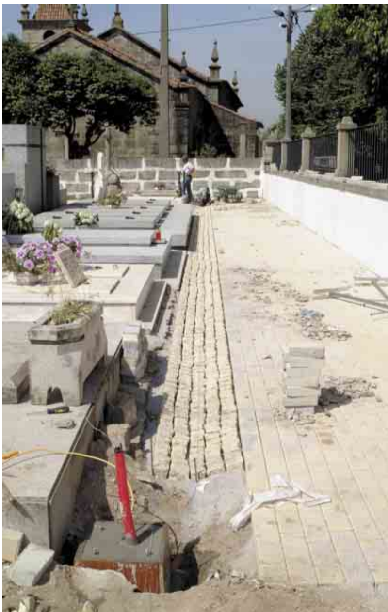
REQUIÃO Renovação do Cemitério Paroquial
