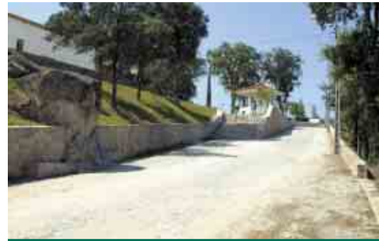
LOURO Reabilitação do Parque do Santo do Monte
