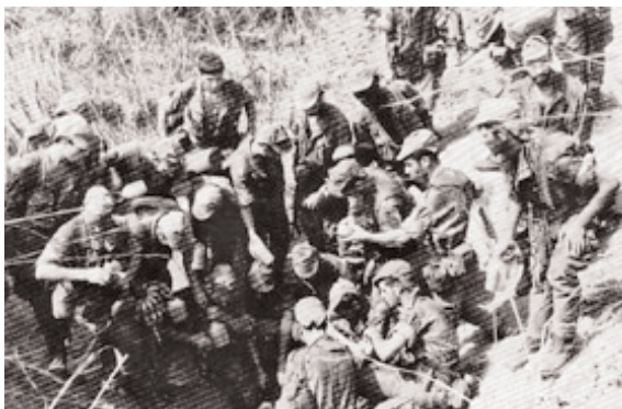
▲ Fig. 11 – Abastecimento de água.
