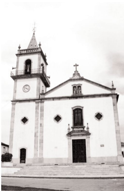
▲ Igreja Paroquial construída em 1954
