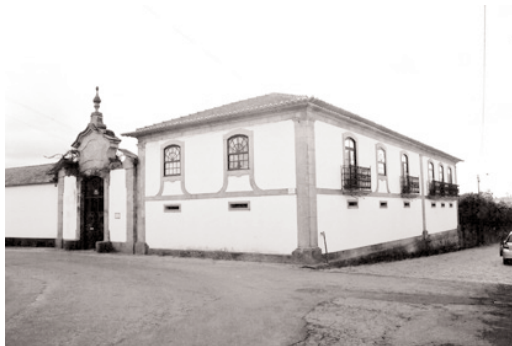
▲ Casa de Pousada de Cima – Bairro
