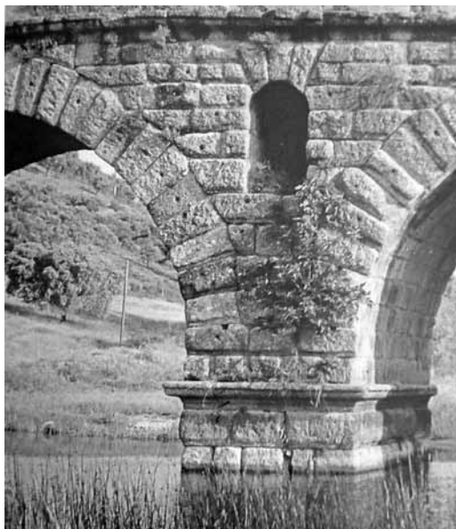
▲ Fig. 5 Ponte de Ribeira de Seda com olhal no tímpano, imposta no pegão e vincos nas aduelas.
