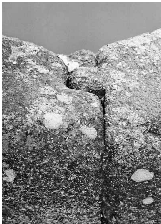
▲ Fig. 12 Encaixe entre dois silhares das guardas de um tabuleiro de ponte românica.
