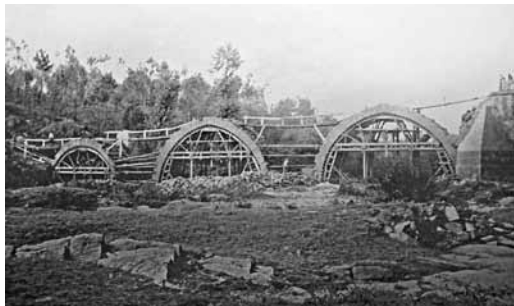
▲ Fig. 21 Ponte da Lagoncinha numa das fases do seu apeamento para restauro
