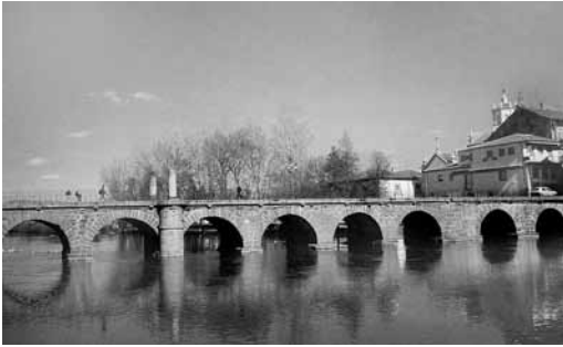
▲ Fig. 1 Ponte de Chaves com dois marcos miliários sobre o tabuleiro.
