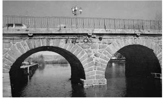
▲ Fig. 2 Parcela da ponte de Chaves cujos dois arcos apresentam as aduelas almofadadas com vincos e o pegão com a imposta.
