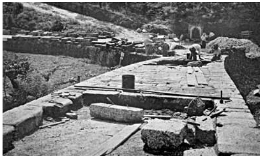
▲ Fig. 22 Ponte da Lagoncinha. Intervenção no tabuleiro para aplicação de uma cinta em betão armado, mas que vai ficar sob o lajeado.
