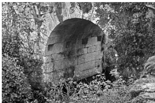
▲ Fig. 14 Agulheiros num vão de uma ponte românica.
