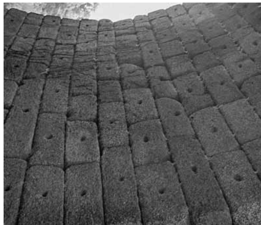
▲ Fig. 7 Ponte de Torre de D. Chama. Vincos nas aduelas do vão.
