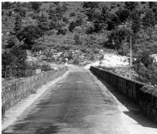
▲ Fig. 6 Ponte de Torre de Dona Chama. Tabuleiro incorporado na E.N.315
