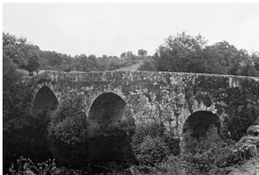
▲ Fig. 25 Ponte românica de Vila da Ponte
