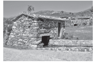
Moinho de água da Montaria; Reabilitação; Viana do Castelo.
