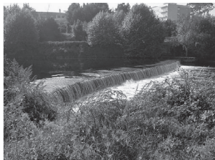
Açude da Azenha da Agra da Bragadela; Ribeirão; V.N. Famalicão.
