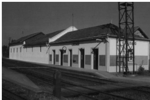
Estação de Lousado.
