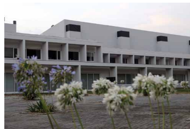
Edifício do CITEVE renovado no âmbito da parceria
