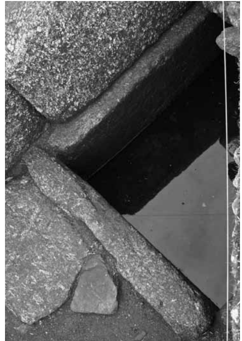
2 - Pormenor do enchimento do tanque após a finalização da escavação no qual é visível o elevado grau de estanqueidade e a operacionalidade do sistema de abastecimento de água.
