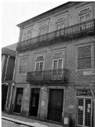
Casa do Senador Joaquim José de Sousa Fernandes, Rua Adriano Pinto Basto., V.N. de Famalicão. Património Municipal.
