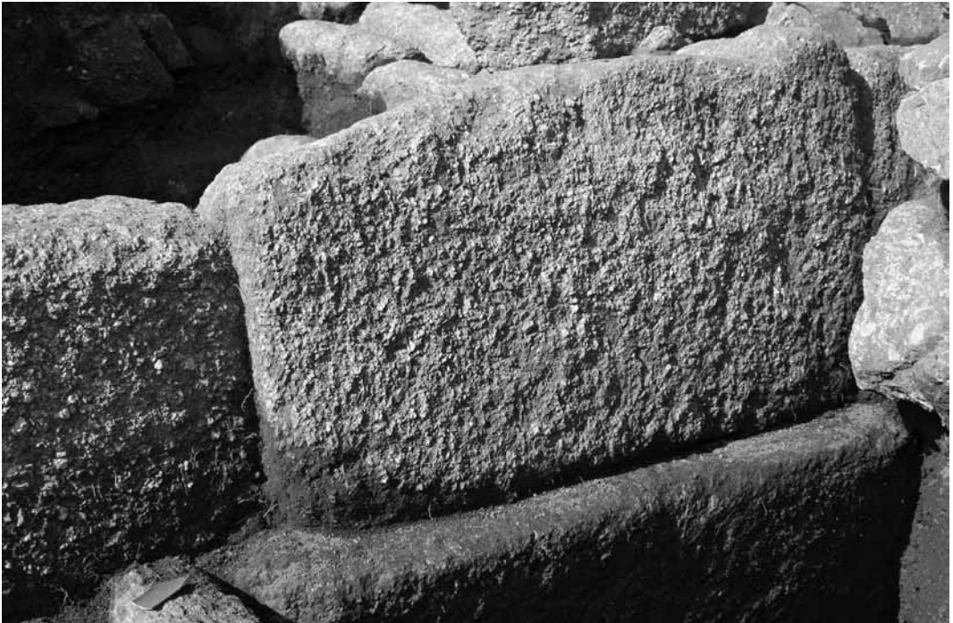
3 – Pormenor do assentamento da primeira fiada do muro oeste do átrio sobre a lage longitudinal do tanque.
