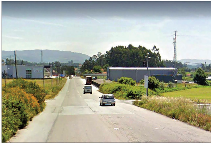
Ligação de Vermoim à Autoestrada 7, em Seide, vai ser alvo de obras profundas
