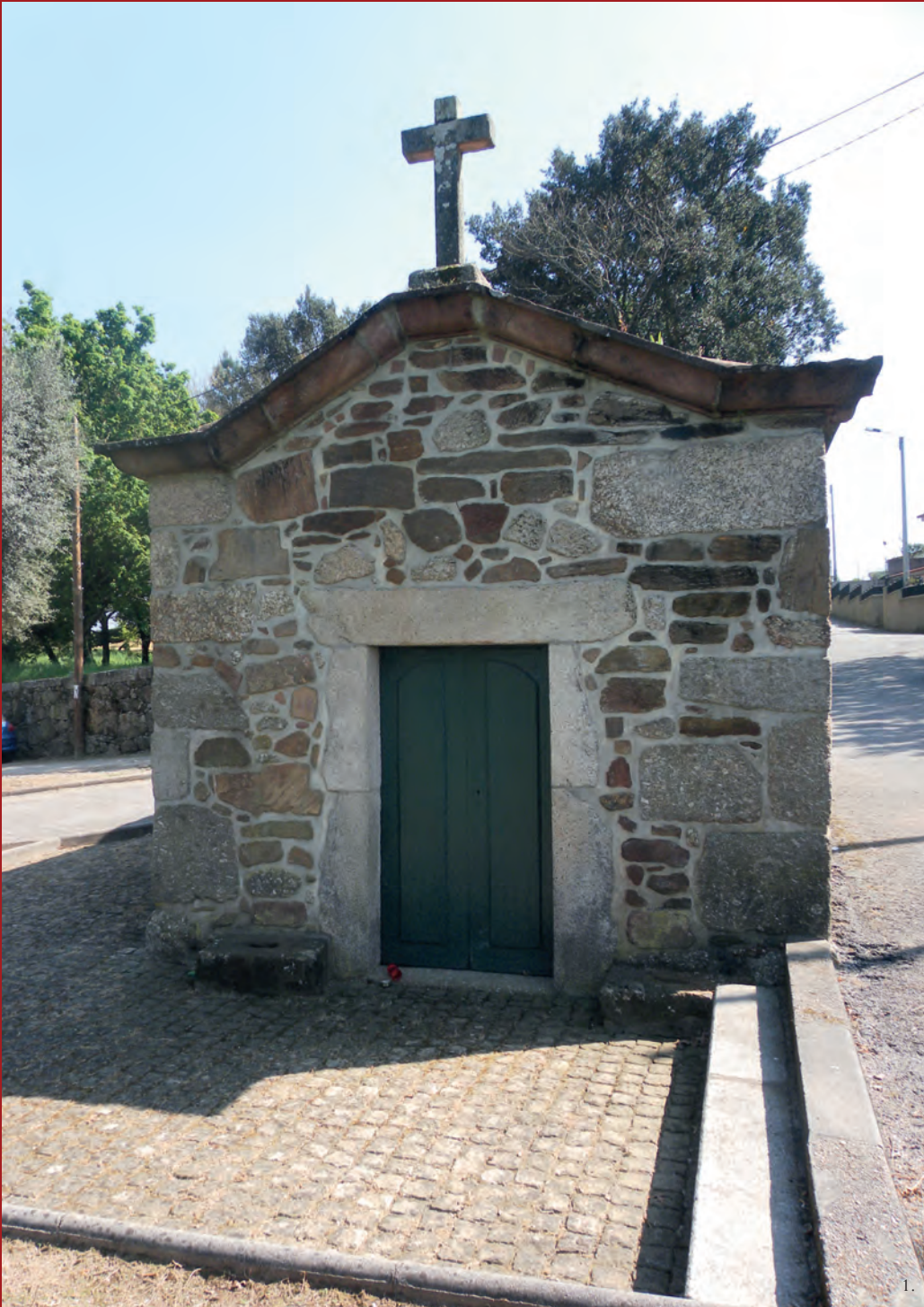
1. Capela de São Paio - Fachada
